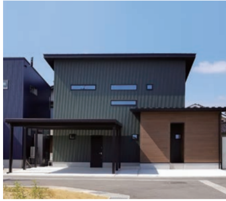
富山市東富山寿町 「36坪で3世帯同居する家」
